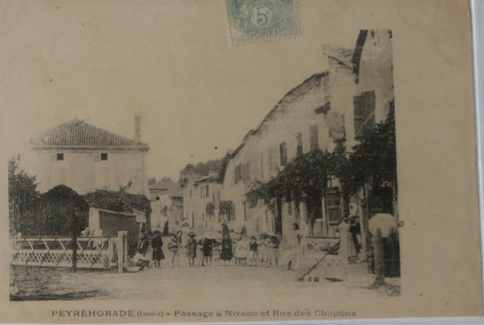
PEYREHORADE (Landes) - Passage à Niveau et Rue des Chapéons
